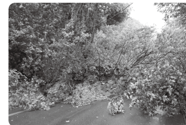
道路の被災状況
