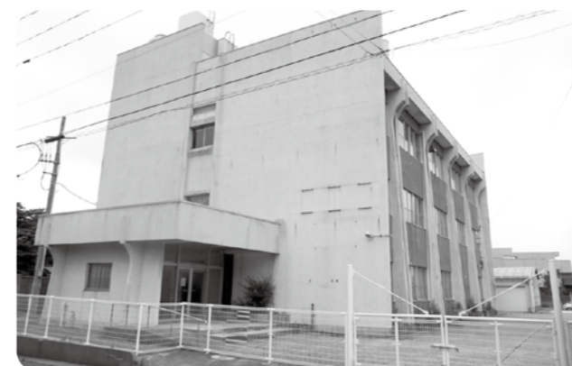
跡地が活用される旧鳥海ダム工事事務所
