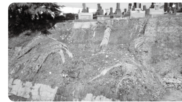
増破した崩落現場
