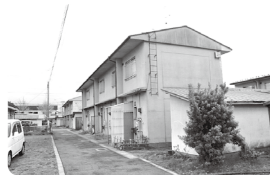
老朽化により解体予定の市営住宅松濤団地
