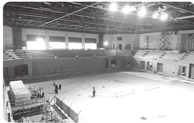
工事中のアリーナ内部
