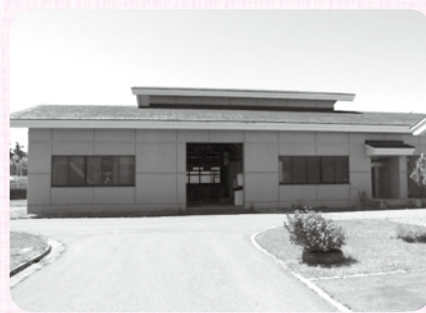
水林浄化センターの汚泥処理棟 (本荘地域)
