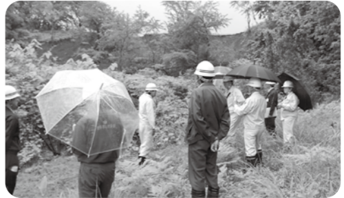
崩落現場の現地調査をする総務常任委員
