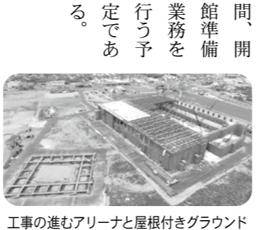
工事の進むアリーナと屋根付きグラウンド
