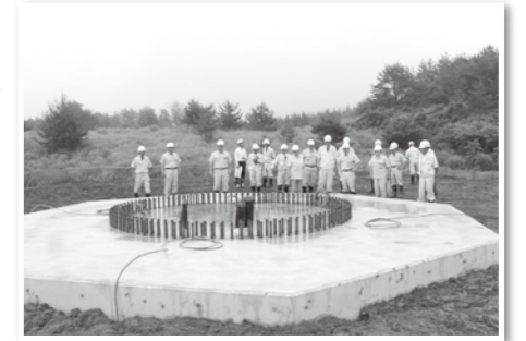
風力発電機の基礎部分
