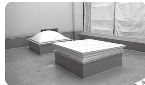
破損箇所の構造を強固に変更
