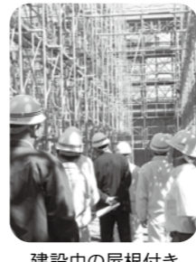
建設中の屋根付きグラウンド内
