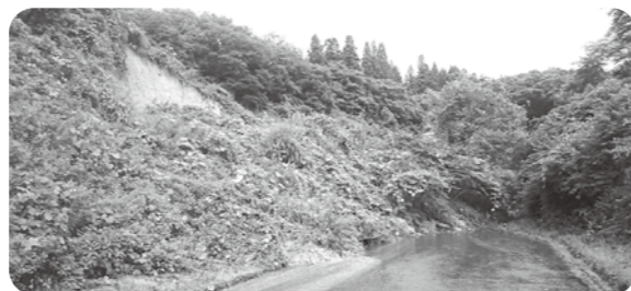
市道軽井沢・羽広・南外線被災状況
