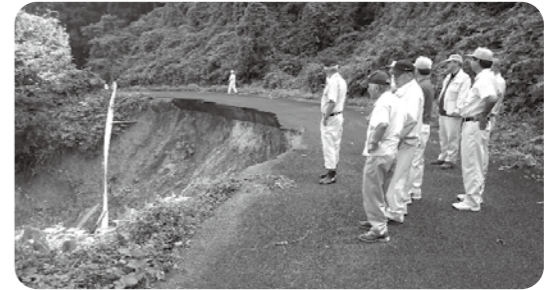
大雨による被害状況の現場を調査
