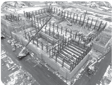
工事の進む総合防災公園のアリーナ
