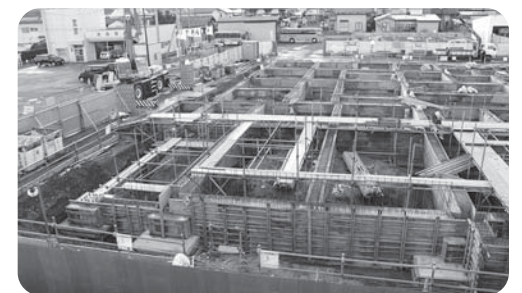
大内総合支所の工事現場
