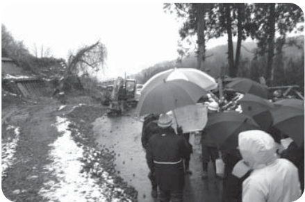
市道吉沢東由利原線災害復旧工事現場調査
