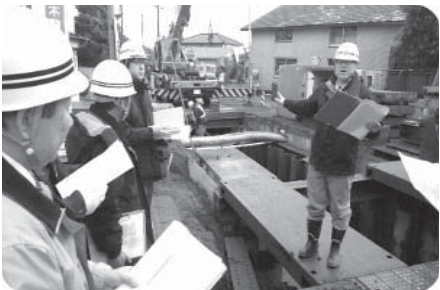
掘削工法の状況調査
