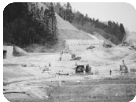
順調に工事が進む日沿道
