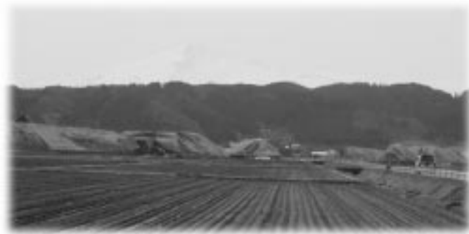
急ピッチで進む日沿道の建設工事
