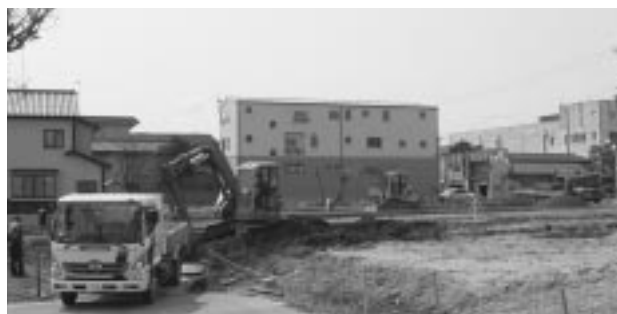
工事が進む本荘中央地区土地区画整理事業
