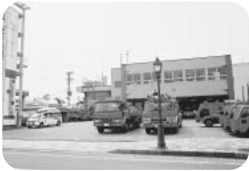
老朽化・狭隘化の消防庁舎
