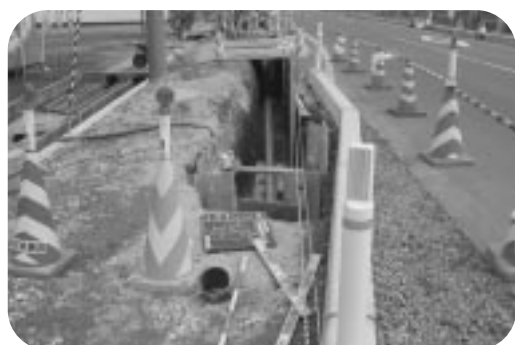
進むガス導管敷設工事
