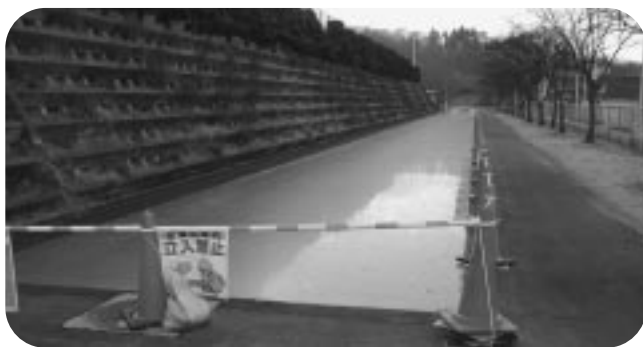
事前着工を指摘された練習用サブトラック
