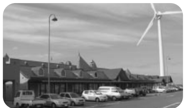
復旧が待たれる風力発電機
