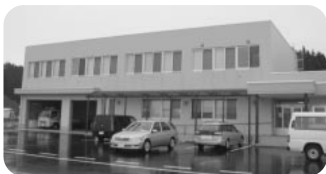
日沿道の安全を守る本荘ステーション
