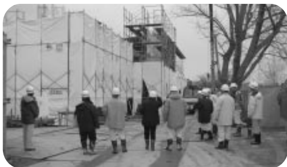
建設工事の中の本荘南中学校
