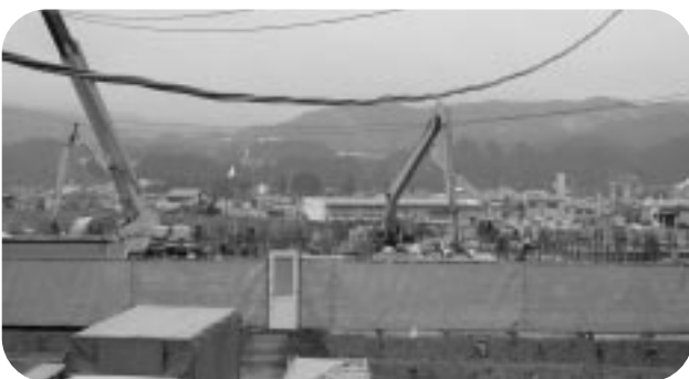
建設工事中の矢島中高連携校
