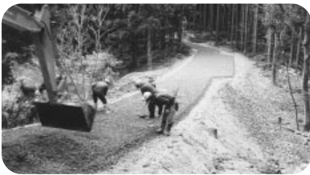
作業道の整備
