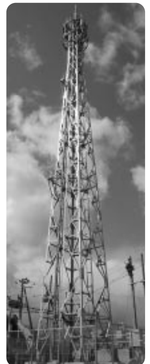
2基整備が計画されている移動通信用鉄塔
