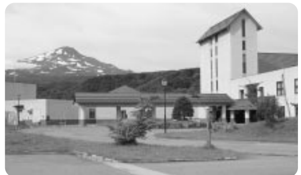
3号井の掘削により温泉の安定供給が期待されるフォレスト鳥海
