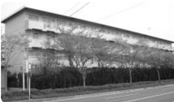
天井改修される本田仲団地
