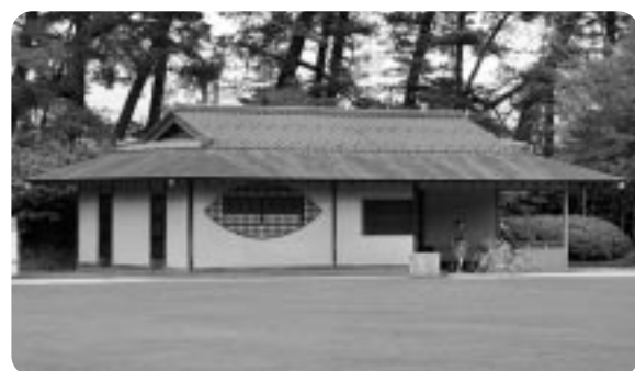
本荘公園内トイレの照明はLEDに
