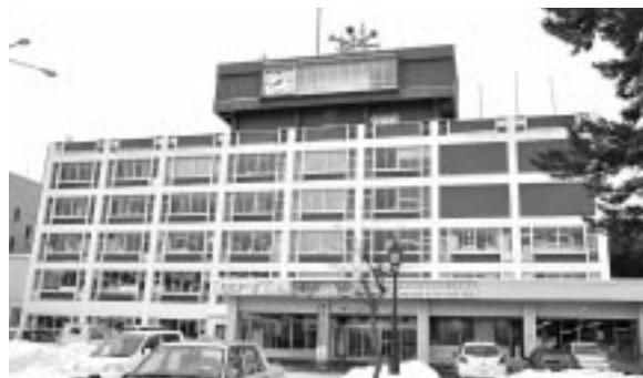
耐震補強が検討されている市役所本庁舎
