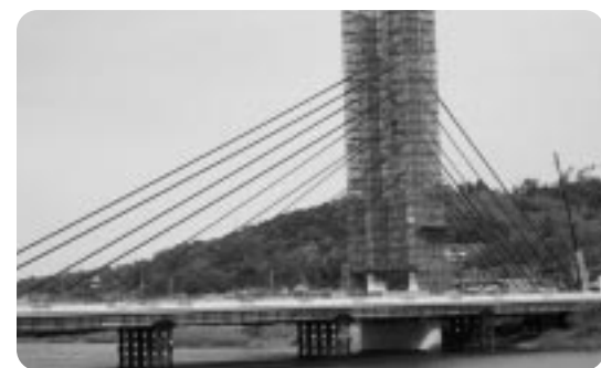
ライトアップが予定される由利橋の架替工事
