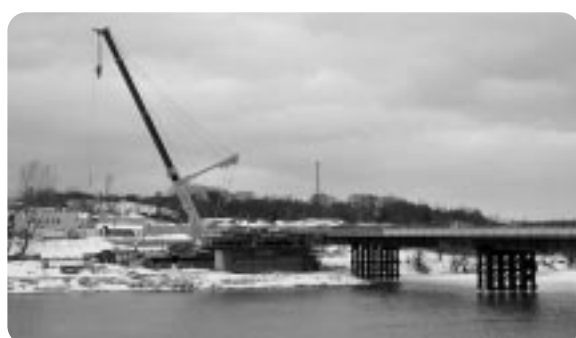
増額の変更契約となった由利橋架替工事
