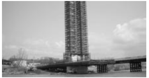
由利橋架替工事
