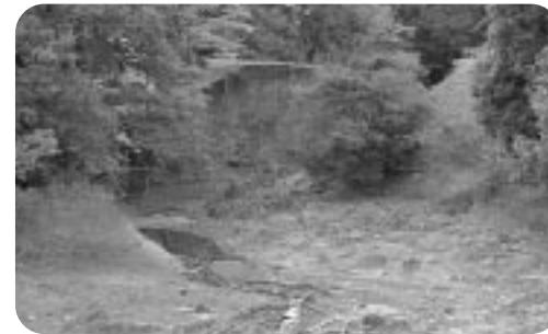
堤体が決壊した勘兵工ため池(大内地域)
