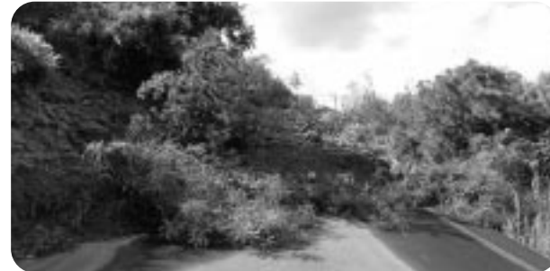
法面崩落で通行止めとなっている市道孫七山猿田線(西目地域)
