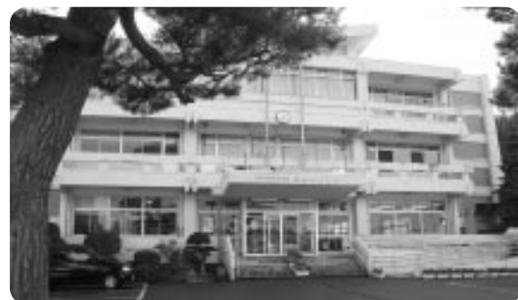
改築予定の矢島総合支所
