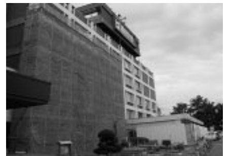
耐震改修工事中の本庁舎
