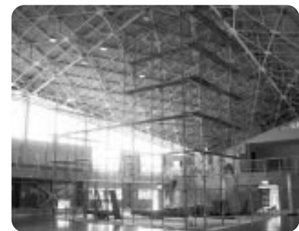
耐震診断を行っている石脇体育館
