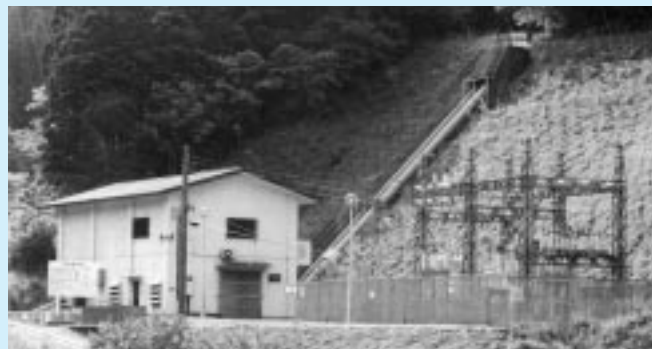
西目発電所の全景
