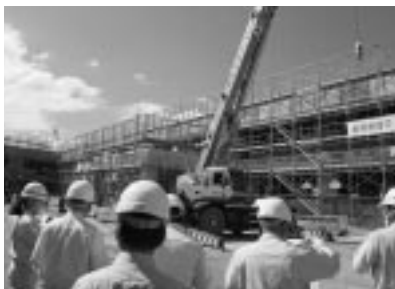
進捗状況を現地調査で確認(9月11日)
