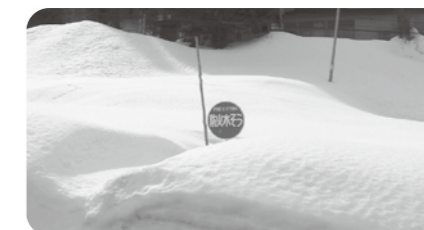
使用不能となっている有蓋貯水槽
