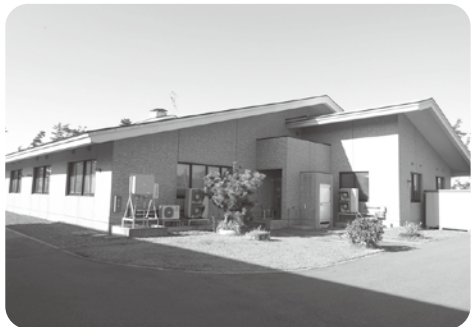
現在の水林浄化センター
