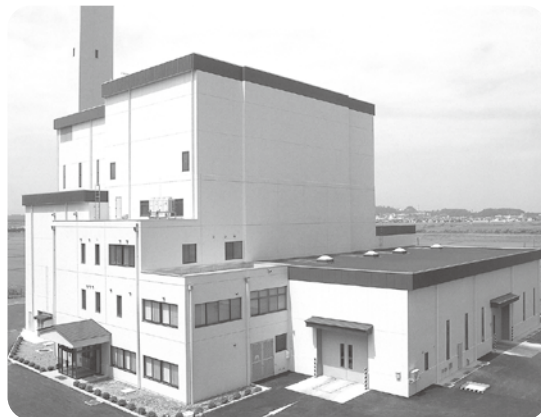
基幹的設備改良を終えた本荘清掃センター
