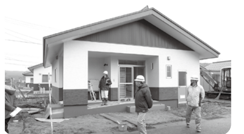
完成直前の東町会館 木造平屋建て(延床面積79.88㎡) 現地調査実施
