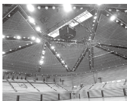
大田区総合体育館
