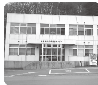
本庄清掃センター事務所棟
