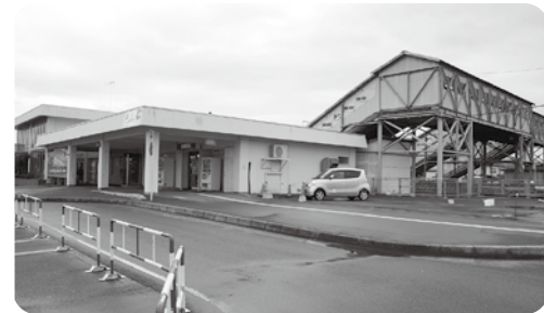
羽後本荘駅舎・跨線橋の現況
